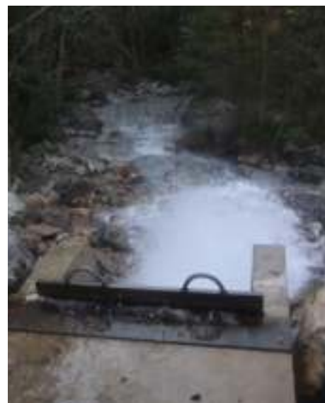
Ci-dessous le déversoir
